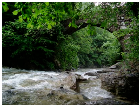
Pont de la Salgueda
